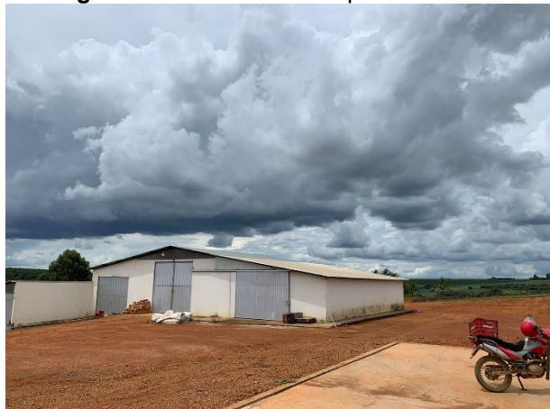
Figura 02: Barracão do empreendimento.
