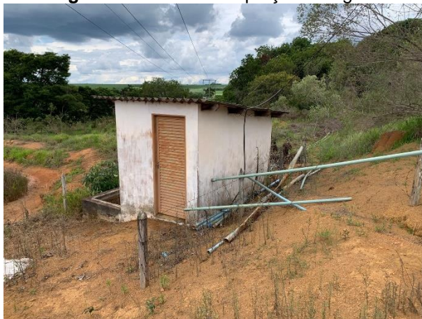
Figura 13: Ponto de captação de água.
