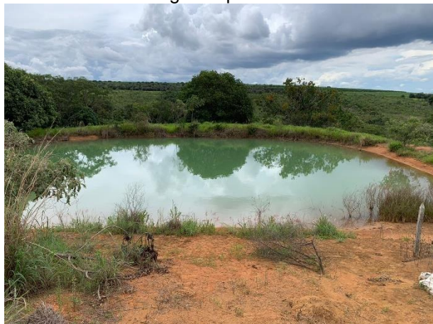
Figura 12: Reservatório para armazenamento da água captada.
